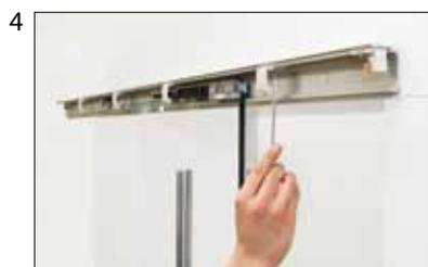
Accrochage des fixations pour le capot avec la même clé Allen
