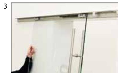
Montage du vantail dans le rail par le devant
