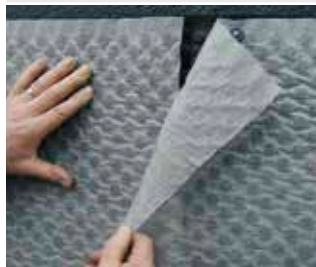
Recouvrement de Fonda GTX.
