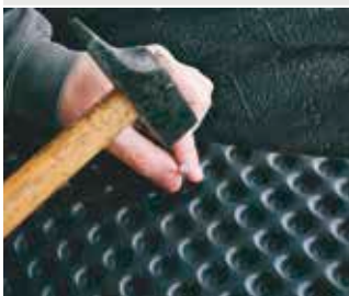
Fixation de la membrane Prim'Nap à l'aide des Prim'Nap fixations.
