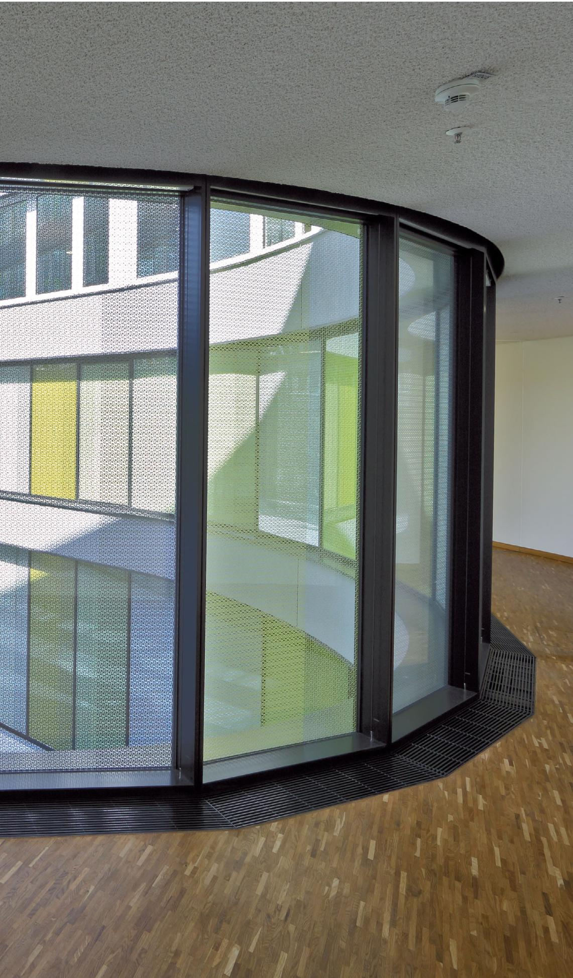
Dans le nouveau siège de l'ADAC à Munich, une solution spéciale de convecteurs en caniveau Katherm HK avec ventilateurs tangentiels EC à haut rendement énergétique garantit un fonctionnement silencieux et des économies d'énergie. Cette variante à caniveau fournit de l'air recyclé filtré, chauffé ou refroidi à partir du plancher, selon les besoins.
